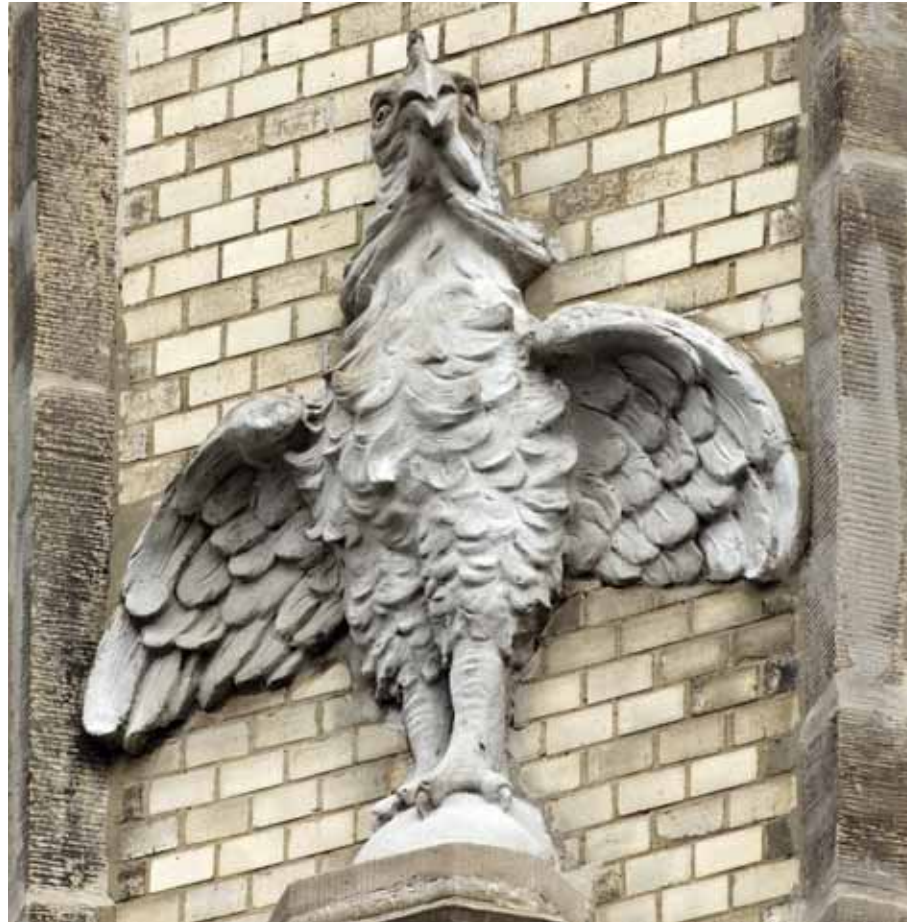
Carl Otto Leheis, 1903, Coburg, Mohrenstraße 9a/b, Facade (Detail), Foto Marburg, Foto: Uwe Gaasch
